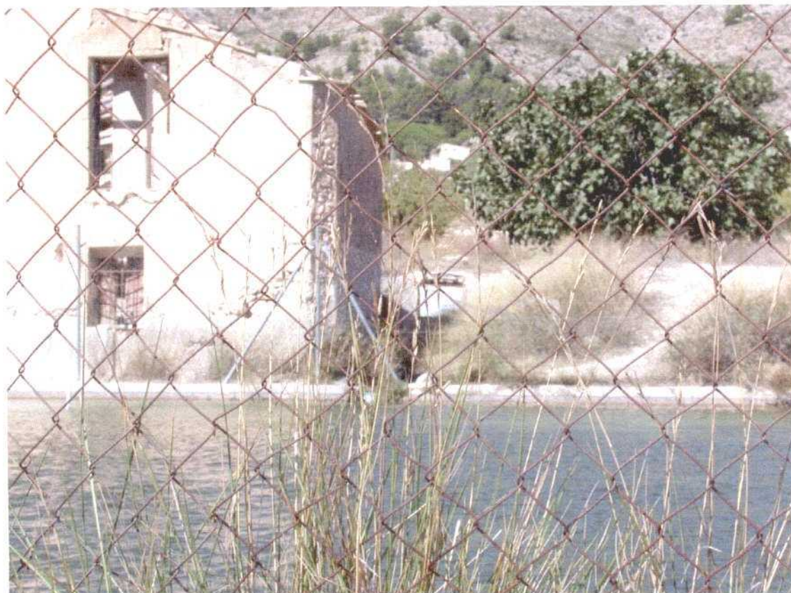
Punto acuífero nº 283320021. Salida a balsa del manantial La Cava.
