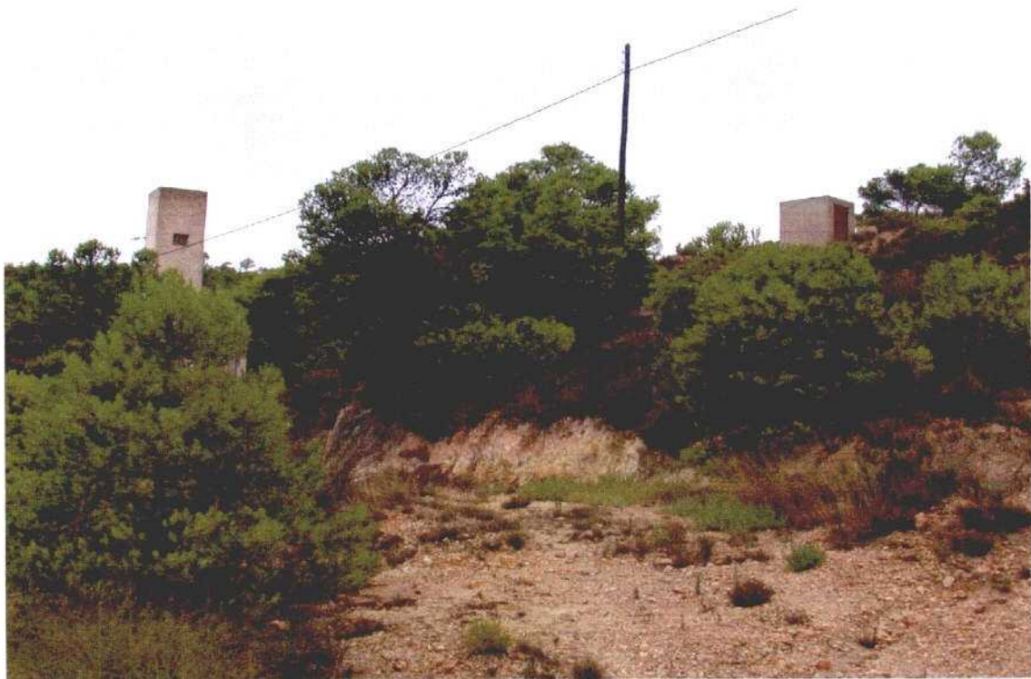
Detalle del punto de captación y transformador del sondeo 283320011
