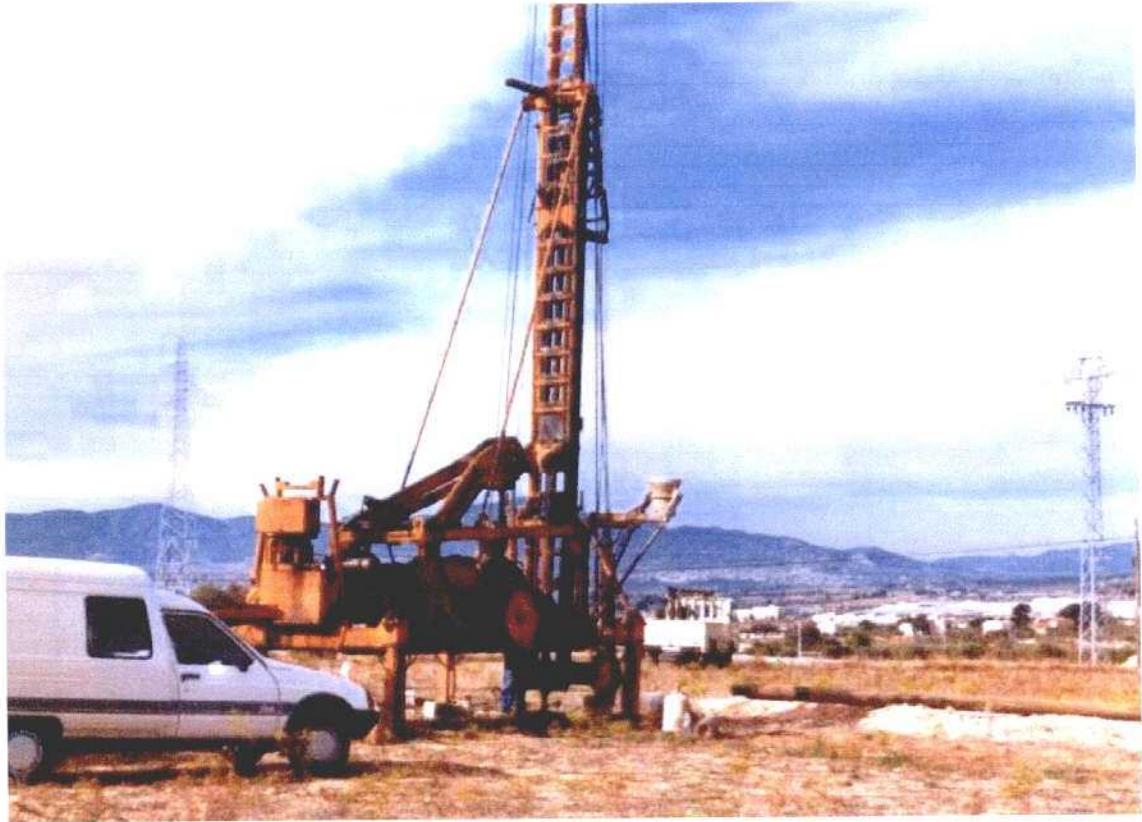
Punto acuífero n° 283340058. Sondeo en ejecución.
