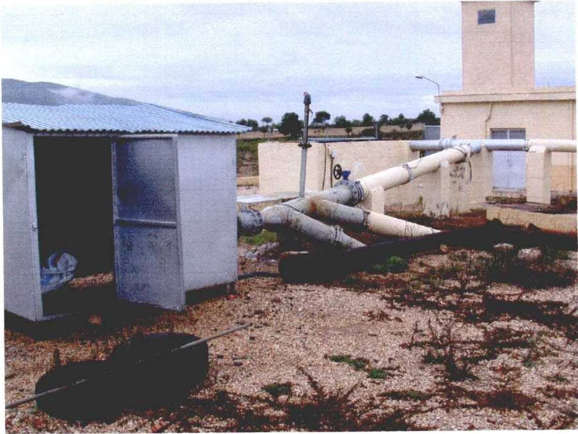
Detalle general del sondeo 283550026, "Pozo San Blas"
